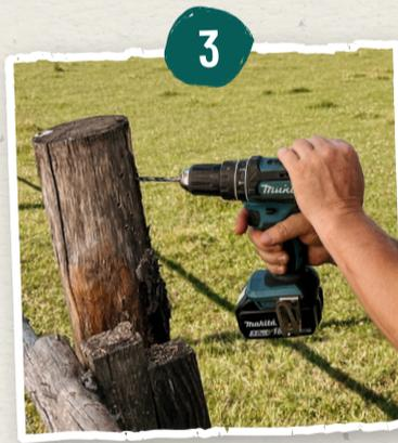
**Schritt 3** Die Löcher so tief wie möglich bohren, aber nicht durchbohren. Das bedeutet: Jedes Bohrloch muss blind enden. Bohre möglichst waagrecht, um zu verhindern, dass Regenwasser eindringt.
